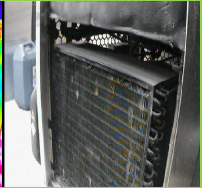
Intercambiador de calor (radiador) con obstrucciones en la tubería del condensador
